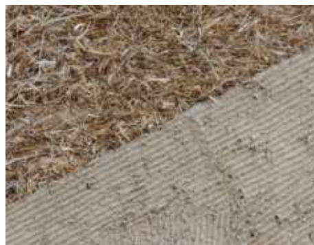
Mit Lehm verputztes Stroh eines Fertigbauteils
