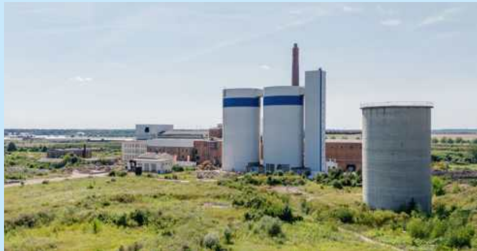
Auf dem Gelände der ehemaligen Zuckerfabrik in Delitzsch entsteht einer von zwei Campus-Standorten des CTC.
