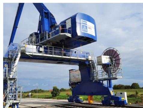
Hebekran, Hafen Torgau
