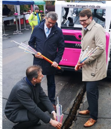
Baustart „Weißer-Flecken-Programm“, Mügeln 2019
