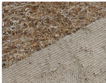
Mit Lehm verputztes Stroh eines Fertigbauteils
